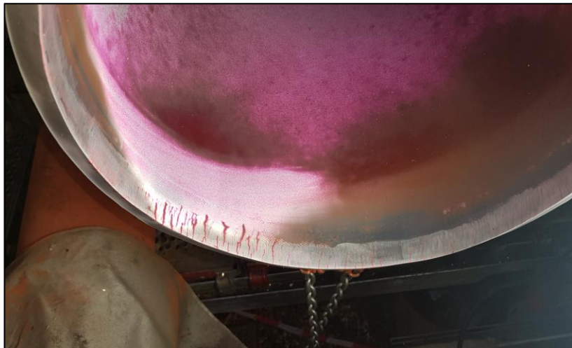
Abbildung 2: PT Anzeigen am verbleibenden Rohrabschnitt im Bereich der Rundnaht – die Schweißkante ist bereits vorbereitet
